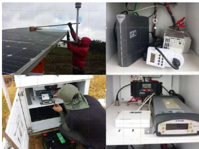
Mantenimiento de estaciones geodésicas GNSS permanentes
